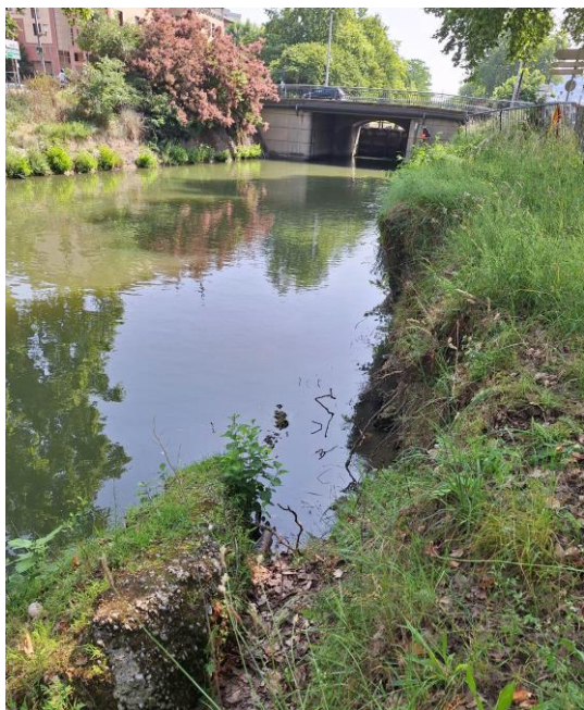
Lentille d'érosion en rive gauche, avec mur partiellement effondré
