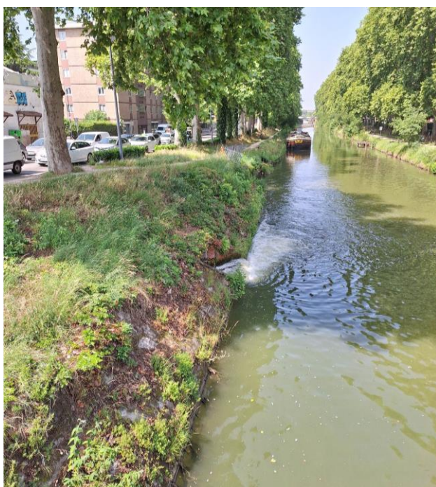
Perré maçonné en amont, en rive gauche
