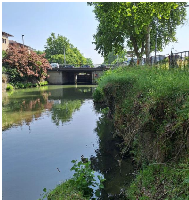
Lentille d'érosion en rive gauche, avec mur partiellement effondré
